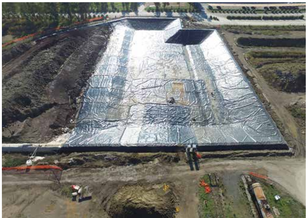
Completamento dell'impermeabilizzazione del lotto 2
